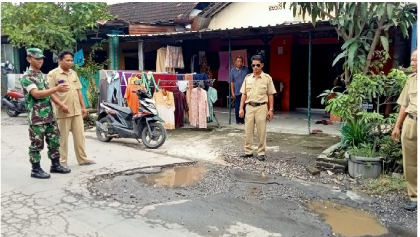
Jalan Rusak, Babinsa Wonosari Cek Kondisi Jalan Bersama Pemdes
